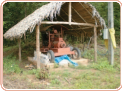
Figura 4.10: Gerador de energia
