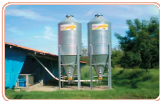
Figura 4.9: Silo para armazenagem da ração na granja
