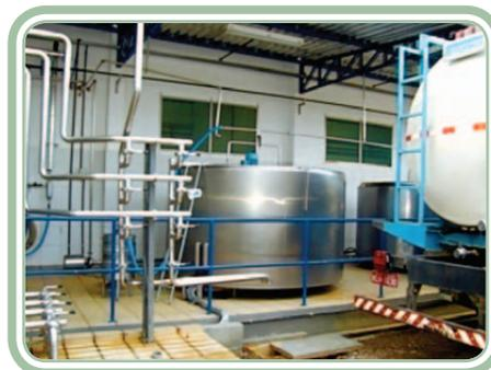
**Figura 4.4: Tanques de expansão para recepção do leite**
