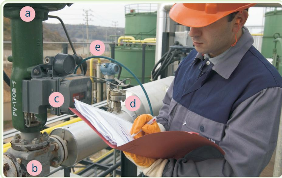
**Figura 7.2: Válvula de controle instalada: (a) atuador pneumático; (b) elemento obturador; (c) transmissor; (d) sensor e (e) ar comprimido**
