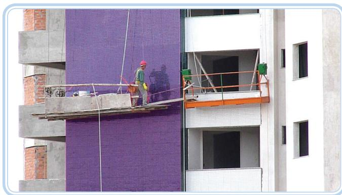
**Figura 2.5: Condição insegura em andaime na construção civil**
